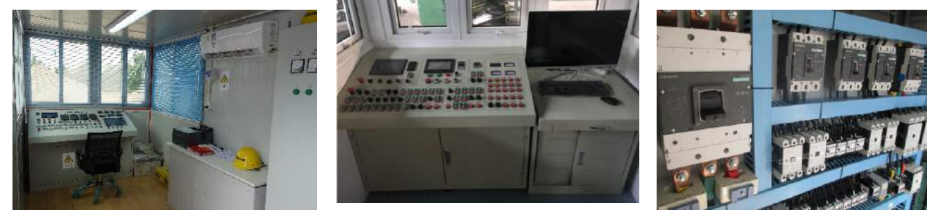
西门子PLC控制系统/ wifi远程监控系统 SIEMENS PLC control system / Remoting control with wifi
